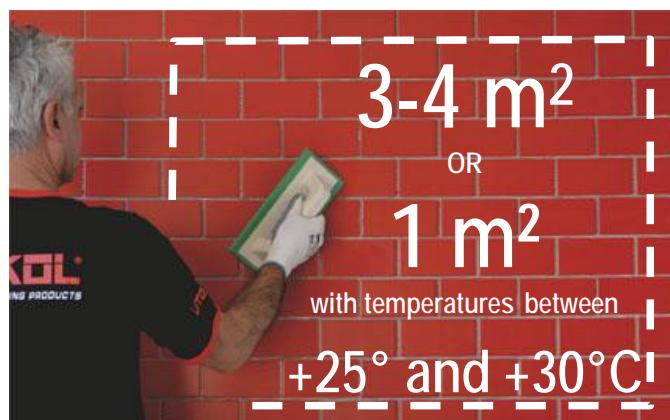
为了便于施工（特别是在炎热气候下），可以在使用产品之前用提供的海绵轻轻润湿瓷砖表面，避免瓷砖表面或空接缝处的水分停滞。这使产品能够更好地施工，延长了填缝剂在瓷砖表面上结皮的时间。
