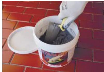
产品的施工需于+10°C和+30°C之间进行。如果气温预报将在48小时内低于+10°C，则不可在室外进行施工。施工后7天内需要保证表面避免碰水。
